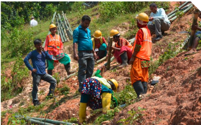
Trabajos de bioingeniería para la estabilidad de los taludes
