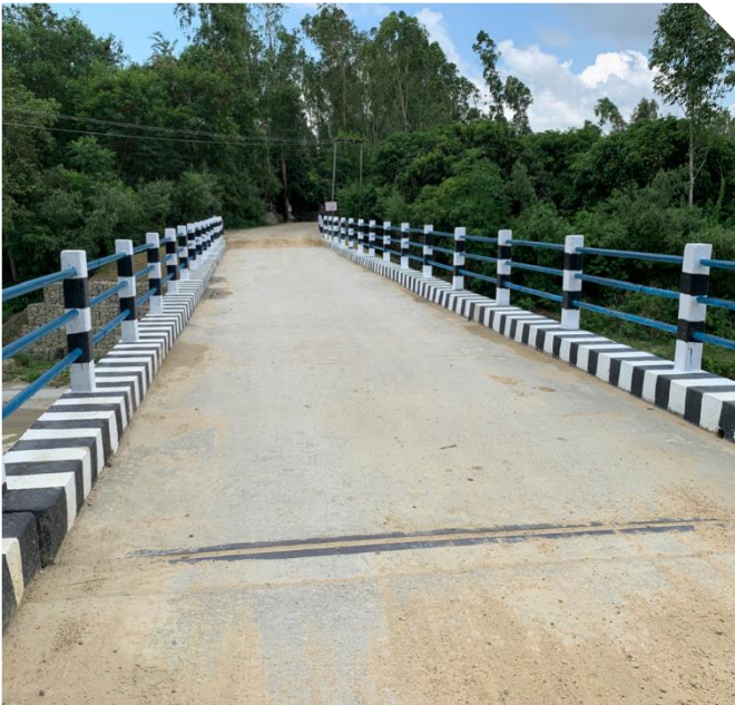
Mantenimiento de puentes
